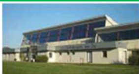
Gymnase Jean Zay Rue Nelson Mandela 77176 Savigny-le-Temple
