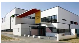
Gymnase Colette Besson Avenue du Clocher 77176 Savigny-le-Temple
